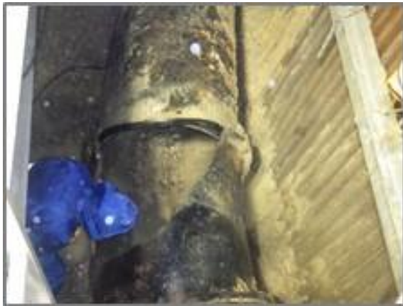
図 3 事故管路掘り上げ状況
